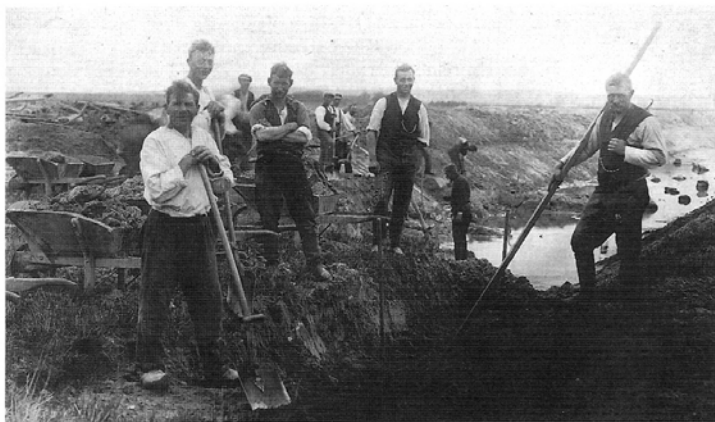
Hinnerup Å's udretning mod øst, 16.4.1927. Der byggedes et stort dige af engtørv, og å-siderne forstærkedes med sammenbundne pæle, nedrammet i bunden.
